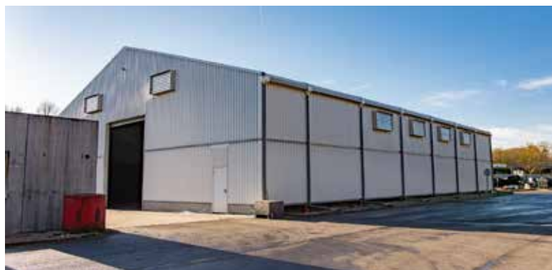
Quai de transfert
